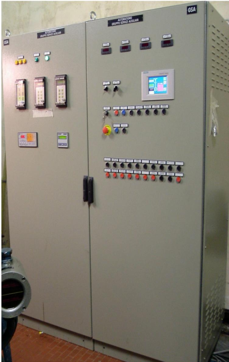
*Il gruppo idroelettrico, da 850 KVA, 400V alimenta solitamente i servizi ausiliari della centrale ma può anche effettuare produzione. I collegamenti di potenza sono stati sostituiti, lato bassa, dall'uscita alternatore fino all'armadio "cento stella" lato alta dall'uscita a alternatore fino ai TA e TV del montante di gruppo.*
